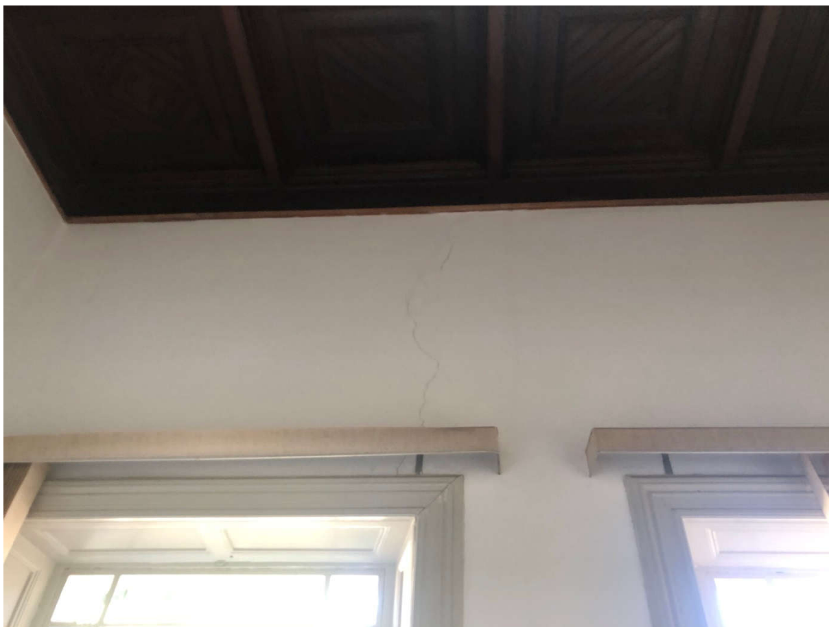
Figura 3.5 – Fissuras nas alvenarias. Edificação da Sede I da SAP, localizada à Avenida General Ataliba Leonel, 556, Santana, São Paulo (SP)
